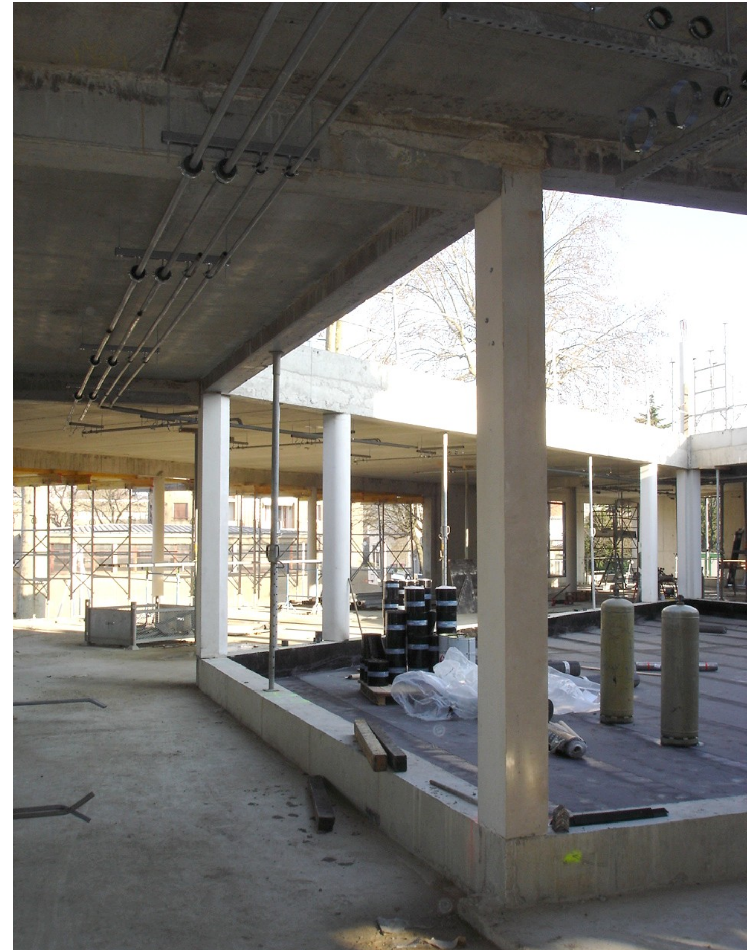
PHOTO DU BATIMENT EN CONSTRUCTION
